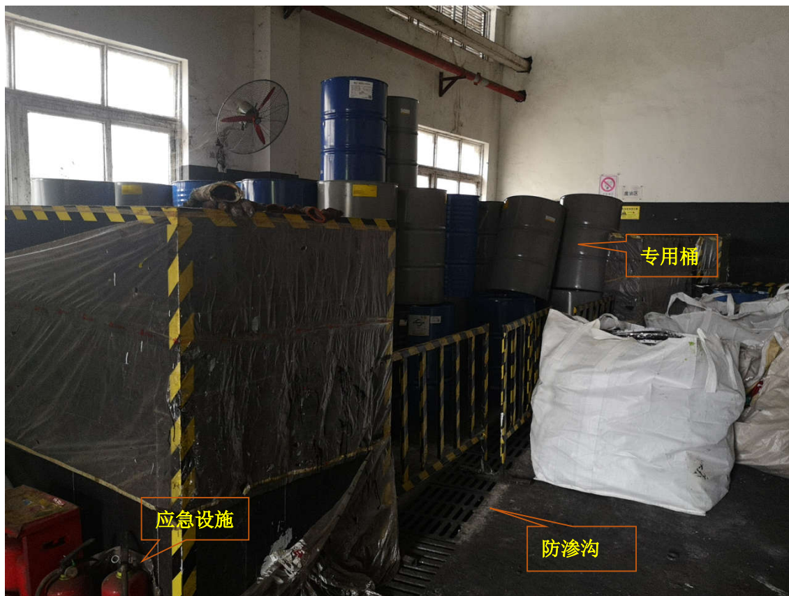
图3.2-13 厂区危废暂存间内部现场图
