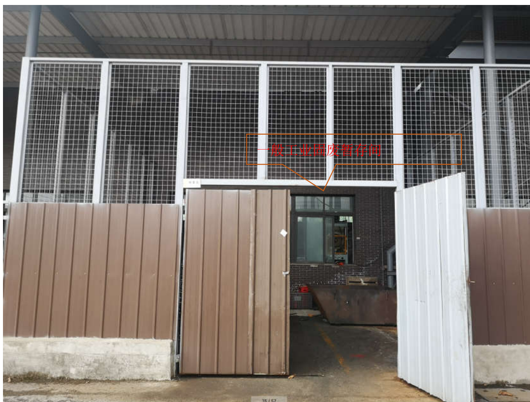
图3.2-12 一般工业固废储存间（废料区）现场图
