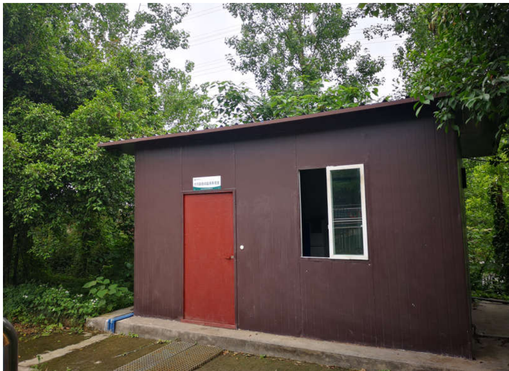
图3.2-11 生产废水处理站现场图
